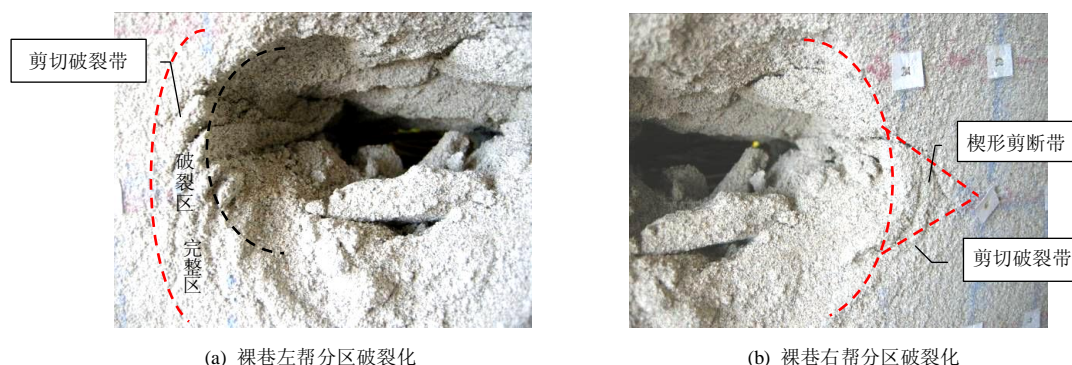
图6 裸巷两帮分区破裂化
