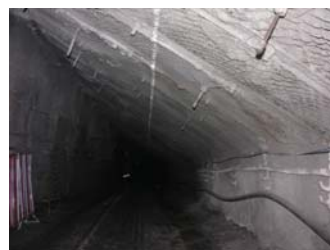
图 5 渗水条件下巷道支护状况
