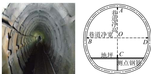
图 6 巷道支架变形监测
