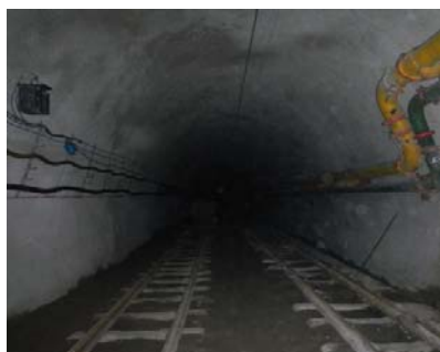
图 11 西翼轨道大巷泥岩试验段支护效果图
