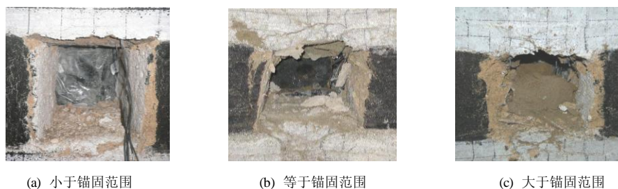
图6 动压影响下不同厚度复合顶时巷道稳定状况
